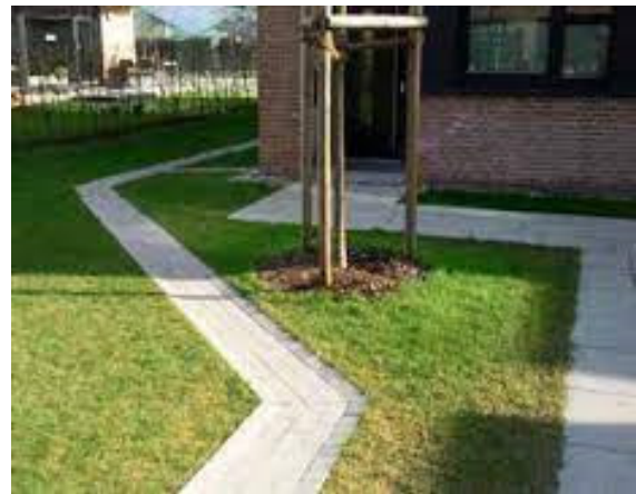
Bild: Mögliche Ausführung einer Pflasterrinne
