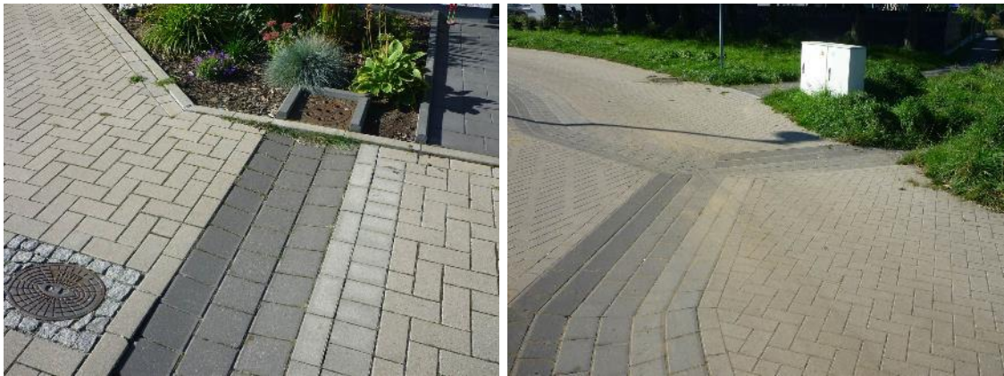
Fotos aus Gladbeck/NRW: Quellschacht, Anschlusspunkt, öffentliche Anschlussrinne, Entwässerungsrinne Straße
